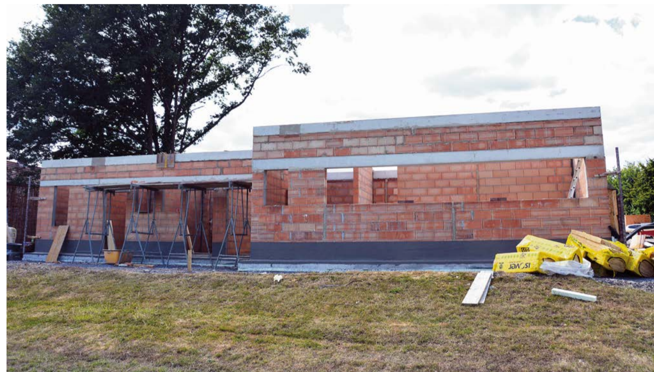
Das neue Umkleidegebäude innerhalb der Sportanlage Vinnum wächst täglich. Das alte Gebäude soll abgerissen werden.
