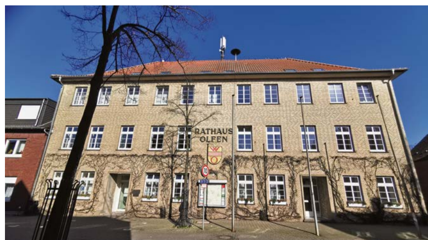
Das Olfener Rathaus stammt in Teilen aus dem 19. Jahrhundert und wird jetzt saniert.
