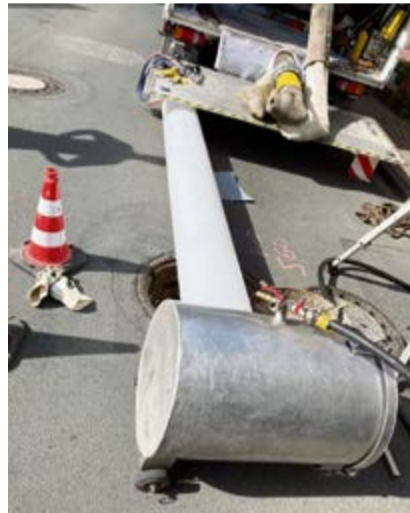
Mörtelverpressung mit Spezialwerkzeug.
