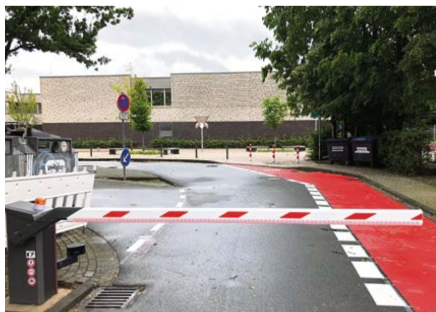
Nach Inbetriebnahme des Schrankensystems in den nächsten Wochen ist die Durchfahrt von 06.00 bis 17.00 Uhr nur noch für Busse und Lehrpersonal möglich.
