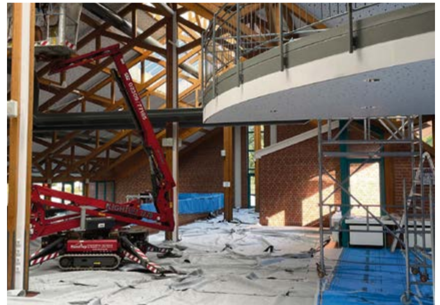
Der Umbau der Mensa der Wolfhelm-Gesamtschule wurde in die Sommerferien gelegt.
