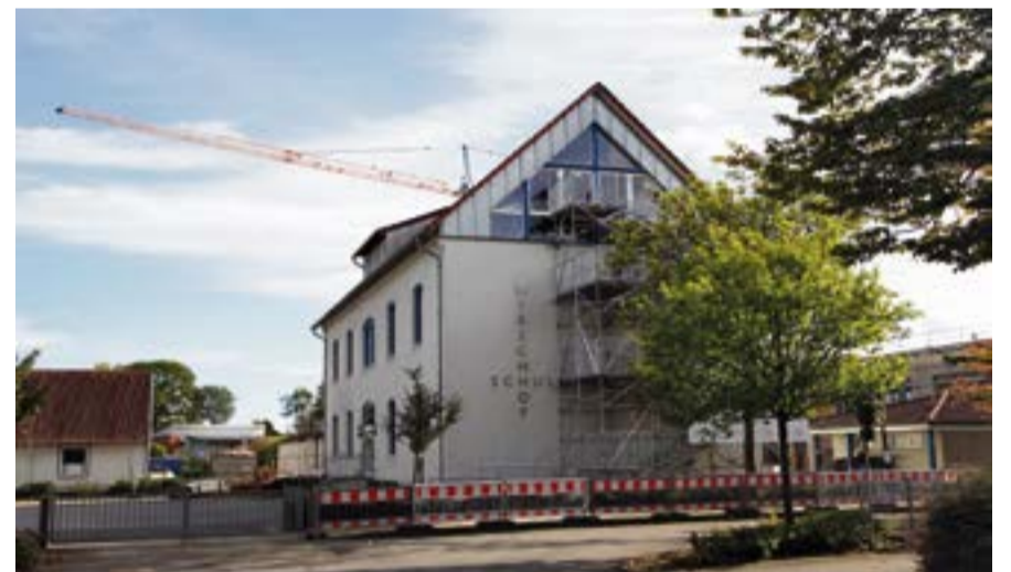
Der Umbau der Wieschhofgrundschule soll in 2018 abgeschlossen werden.
