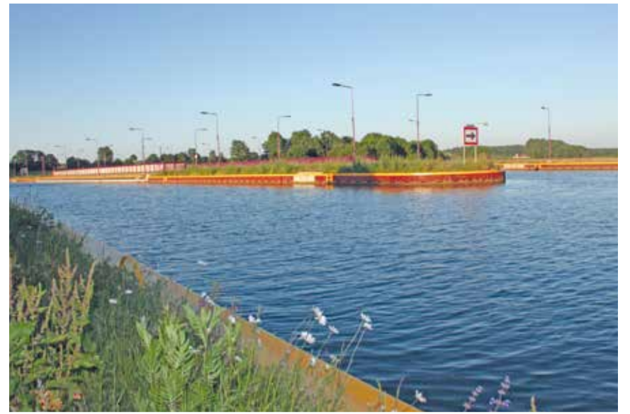
Freie Fahrt für Schifffahrt und Radfahrer. Nach 13 Jahren Bauzeit sind die Arbeiten an der Lippebrücke und am Dortmund-Ems-Kanal beendet.
