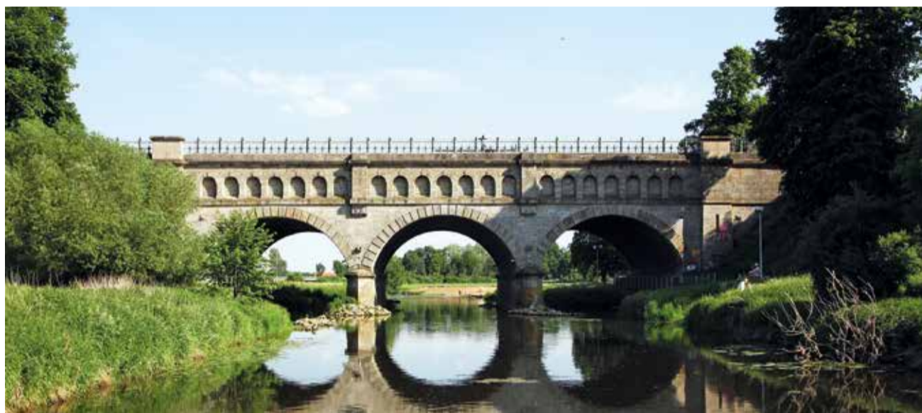
Tolle Ausblicke - wie hier auf die Dreibogenbrücke - sind bei jeder Floßfahrt garantiert.
