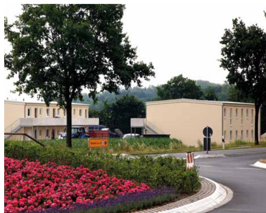
Die neue Flüchtlingsunterkunft im Gewerbegebiet am Vinner Landweg ist Anfang Juli fertiggestellt worden. Sie ist für maximal 118 Personen ausgerichtet.
