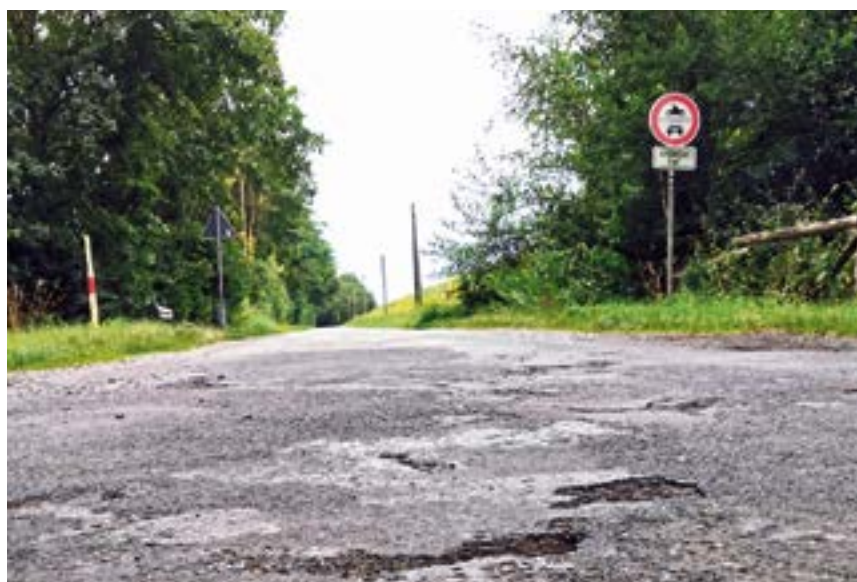
Die Arbeiten zur Deckensanierung am Alten Postweg sollen jetzt beginnen.
