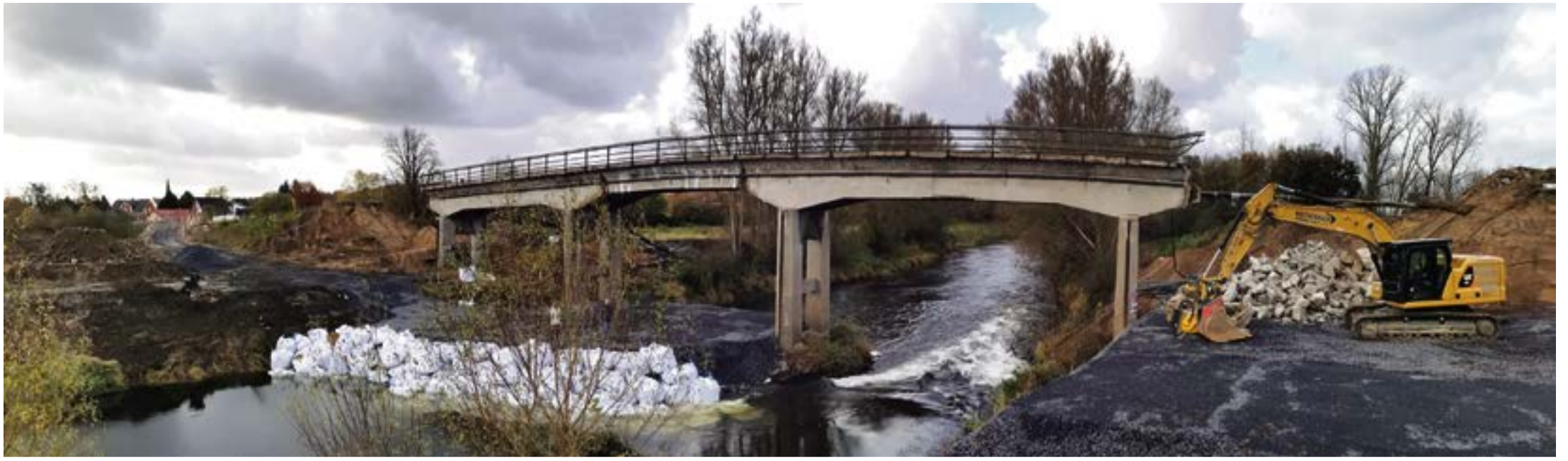
Da stand die alte Brücke noch. Mittlerweile ist sie abgerissen und die Bauarbeiten schreiten zügig voran. Ziel ist, dass der Neubau der Brücke bis Ende des Jahres 2022 fertig sein soll.
