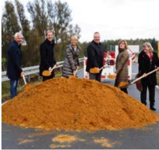
Offizieller Spatenstich zum Neubau der Ahsener Brücke: Ende 2022 soll die neue Brücke fertig sein.
