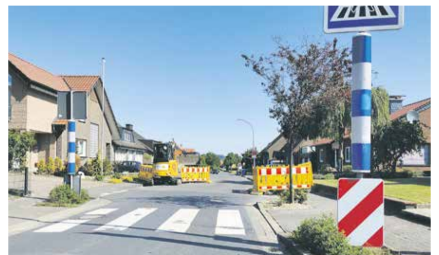
Die Umgestaltung des Eckernkamps hat begonnen und soll bis Ende August andauern. Anschließend werden die Fahrradwege markiert.
