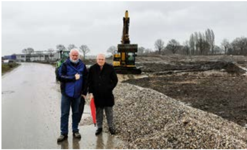
Geschäftsführer Markus Beermann (r.) und sein Stellvertreter Carsten Schmidt freuen sich über den Baubeginn in Olfen: „Hier liegt die Zukunft des Unternehmens!“
