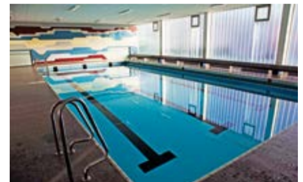
Die Sanierung des Hallenbades ist ab 2021 geplant.
