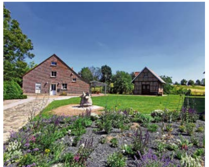
Auf Beschluss des Rates werden Umbaumaßnahmen des Heimathauses mit dem Ziel der Barrierearmut geplant. Fördermittel werden für das Projekt beantragt.
