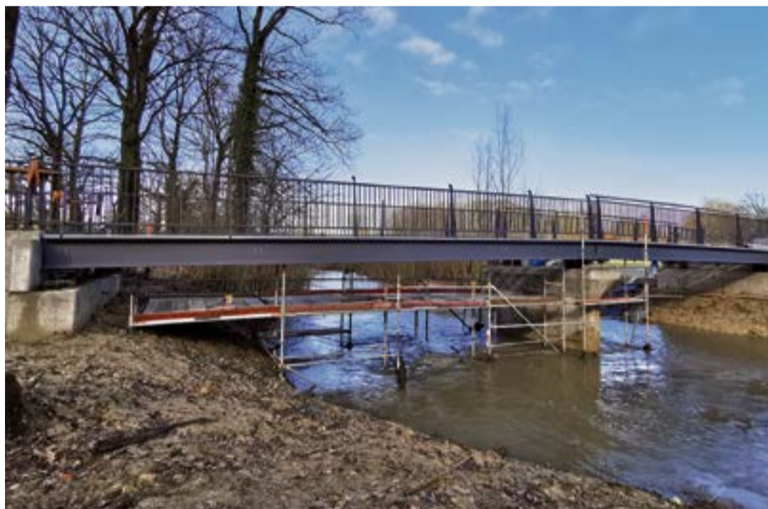
Für die Rad- und Gehwegbrücke wurden insgesamt 4 Hauptträger und 17 Querträger verbaut.
