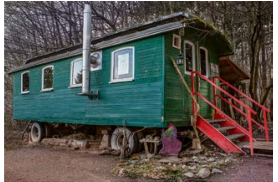
Im Rahmen der Angebote des im Bau befindlichen Naturparkhauses soll auch ein Bauwagen als Lernort für Kinder und Jugendliche eingerichtet werden.
