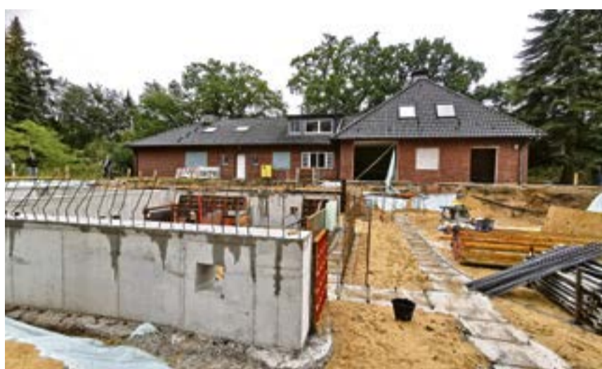
Der Umbau der „Villa Ritter“ zum Naturkindergarten schreitet voran.
