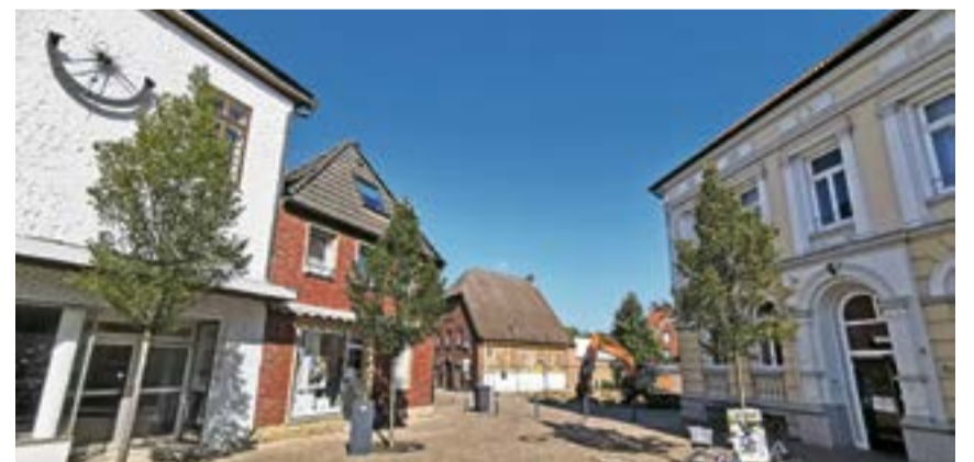
Die ersten Abbrucharbeiten an der Funnenkampstraße haben stattgefunden.
