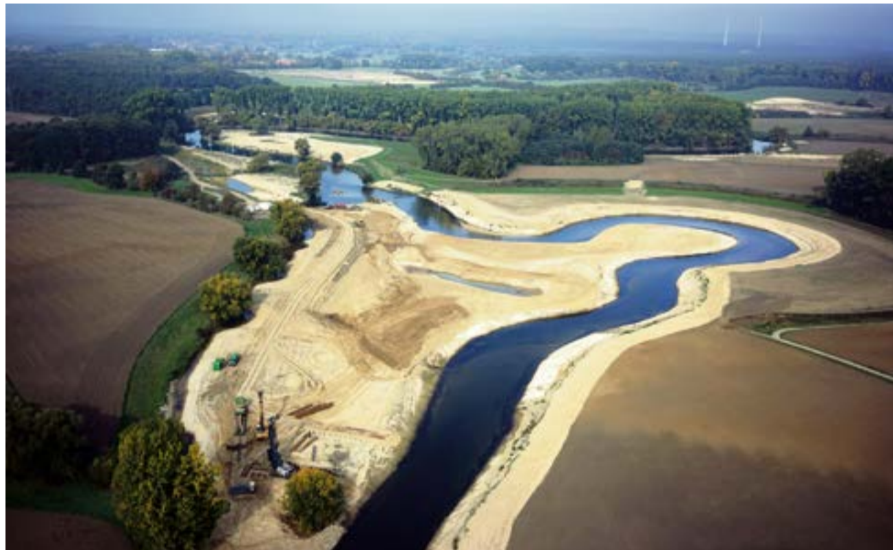
Zwischen Haus Rauschenburg und dem sogenannten „Hälschen“, wo die Lippe bislang recht gerade verlief, verlängerte das Projektteam den Fluss und gestaltete eine neue Schleife. Foto: EGLV
