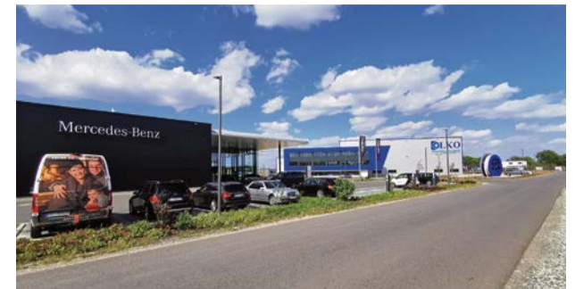
Die ersten Unternehmensgebäude im Gewerbegebiet sind fertig.
