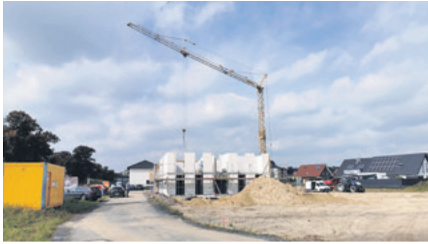
Das erste von acht Mehrfamilienhäusern an der Ächterheide ist im Bau.
