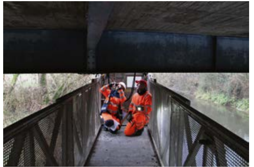
Die Lippebrücke zwischen Vinnum und Waltrop wurde eingehend untersucht.
